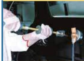
Saldatura con martello estrattore
